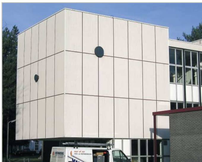
санация бетонного здания, Нидерланды
