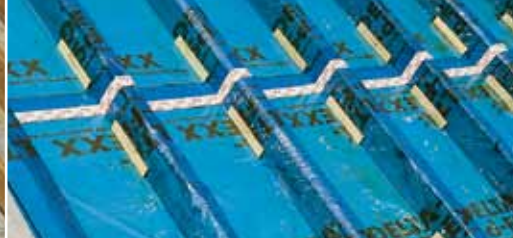
После монтируется DELTA®-Sd-FLEX.
